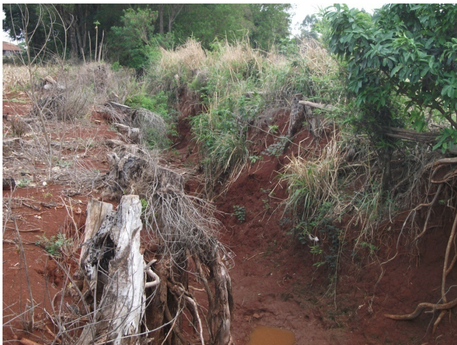
Figura 9: Voçoroca provocada pelo escoamento de águas do centro urbano em direção ao interior do município. Julho de 2011.
