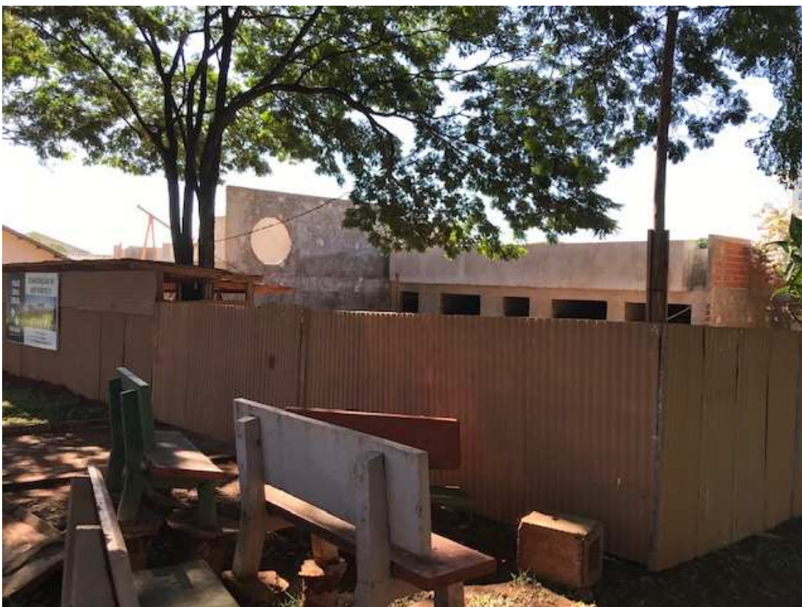
Imagem 12: Obra pública (Posto de Saúde Central), com o canteiro de obra isolado.
