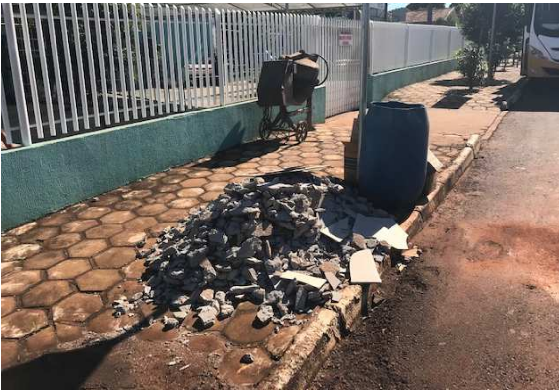
Imagem 03: Disposição de RCC em local inadequado.
