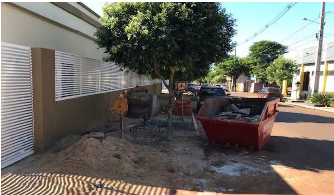
Imagem 01: RCC e caçamba de coleta dispostos em local inadequado.
