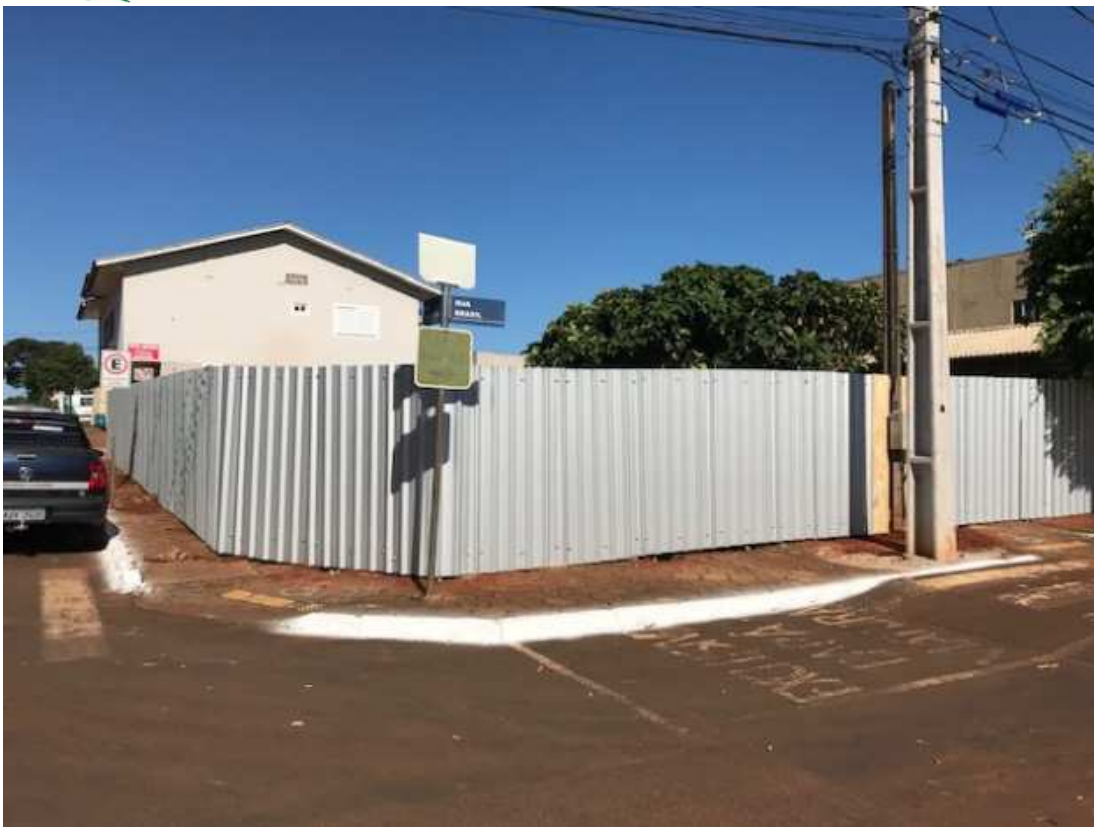
Imagem 11: Canteiro de obra isolado, no centro do município.
