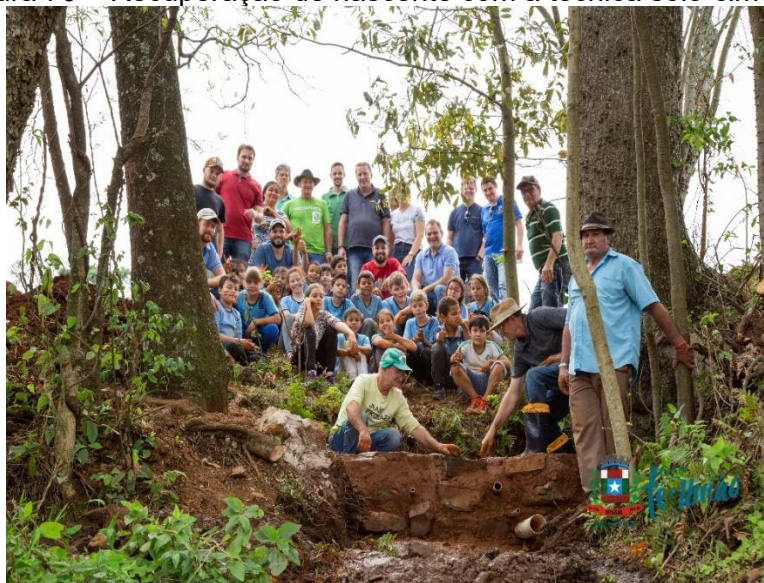
Figura 70 – Recuperação de nascente com a técnica solo-cimento.
