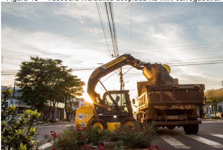
Figura 15 – Vassoura hidráulica acoplada na mini carregadeira.
