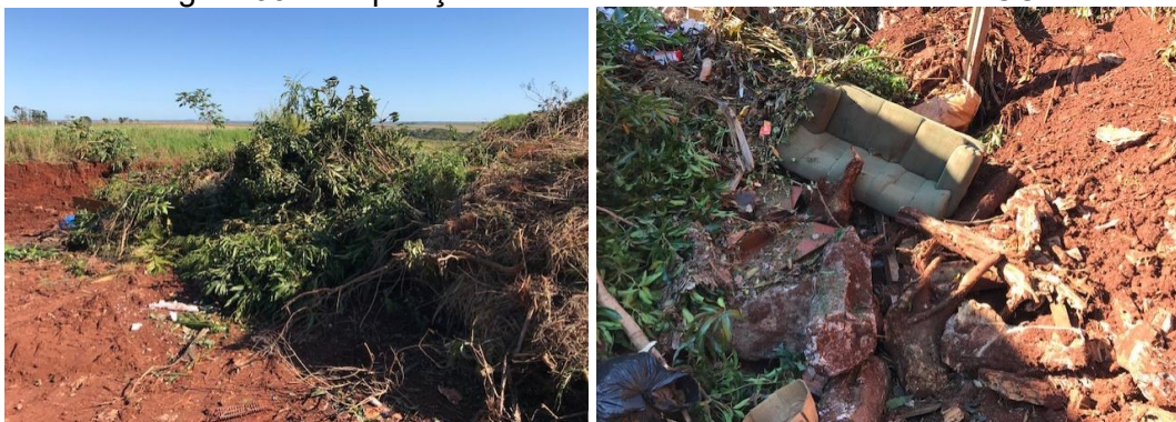
Figura 53 – Disposição de resíduos diversos na área de RCC.
