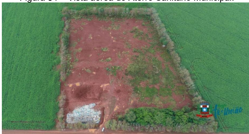
Figura 54 – Vista aérea do Aterro Sanitário Municipal.
