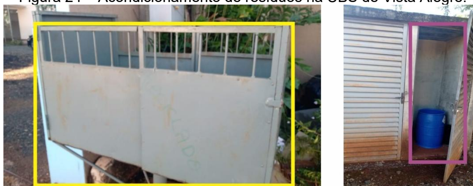
Figura 24 – Acondicionamento de resíduos na UBS de Vista Alegre.
