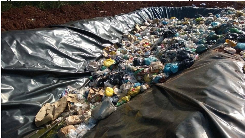
Figura 56 – Impermeabilização das valas com geomembrana.
