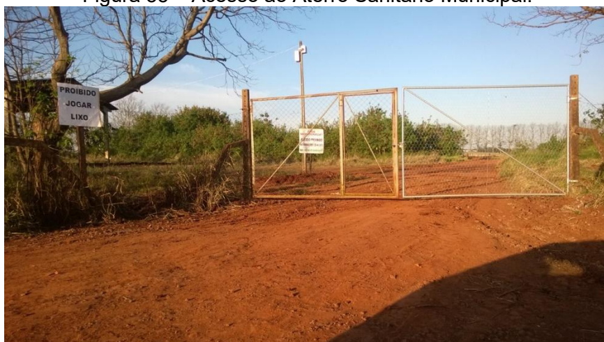
Figura 55 – Acesso ao Aterro Sanitário Municipal.
